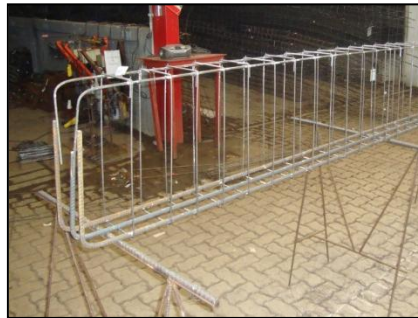
Figura 2 - Montagem (viga estrutural).
