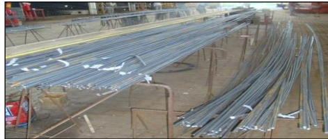
Figura 9 - Barras de ferro cortadas, prontas para marcação e montagem.
